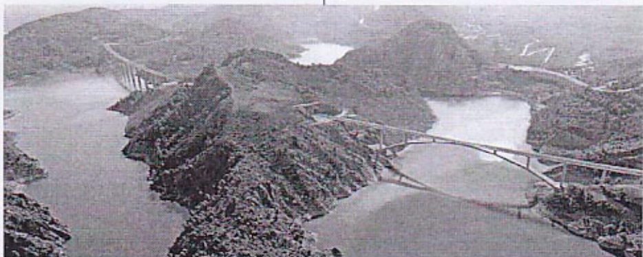
Tres túnels i tres viaductes en només 6,5 km al pas de l'AVE sobre l'embassament de Contreras, a Cuenca.
